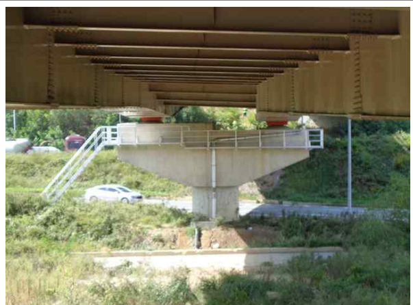
교량 하부 전경
