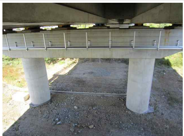
교량 하부 전경
