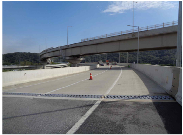
교량 상부 전경
