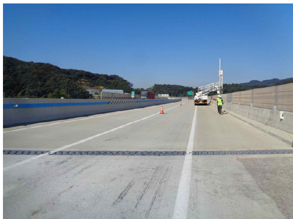
교량 상부 전경
