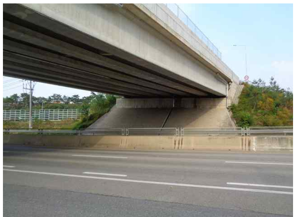
교량 하부 전경
