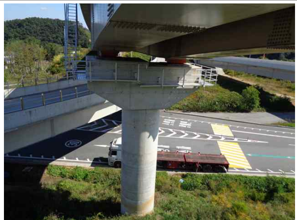
교량 하부 전경
