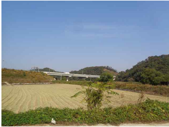
교량 측면 전경
