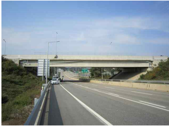
교량 측면 전경
