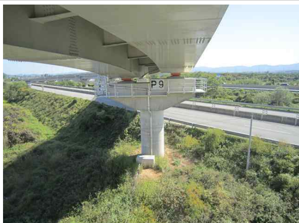
교량 하부 전경
