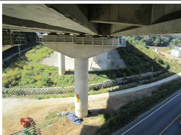
교량 하부 전경
