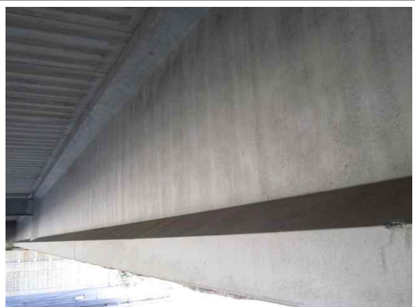
교량 거더 전경
