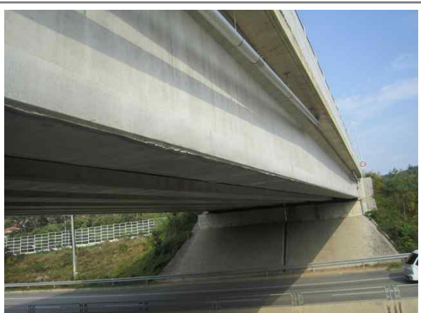
교량 거더 전경
