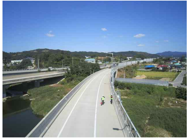
교량 상부 전경
