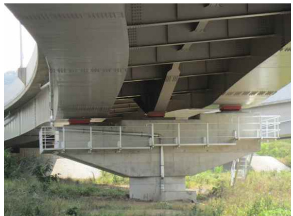
교량 거더 전경
