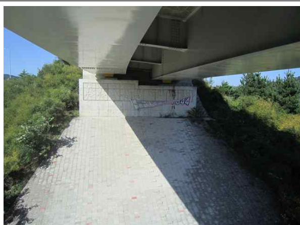
교량 하부 전경
