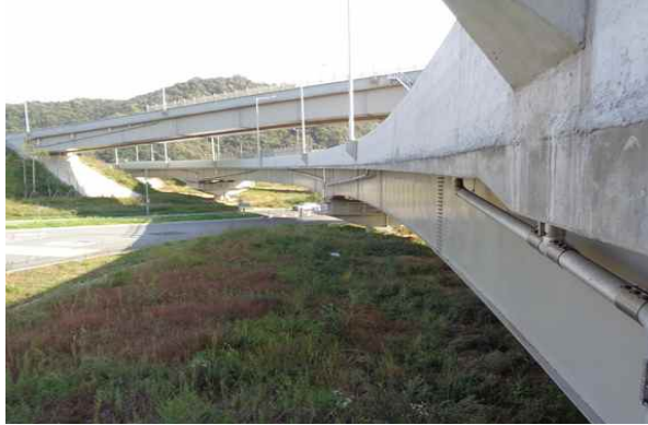
교량 측면 전경
