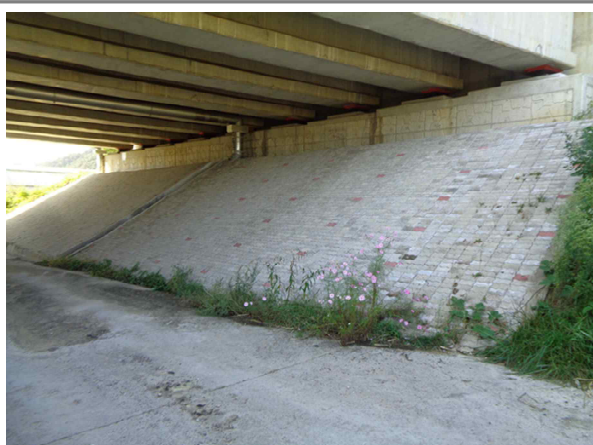
교량 하부 전경
