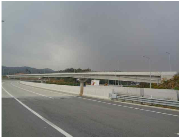
교량 측면 전경
