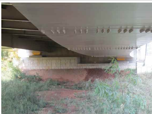
교량 하부 전경
