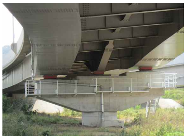
교량 하부 전경
