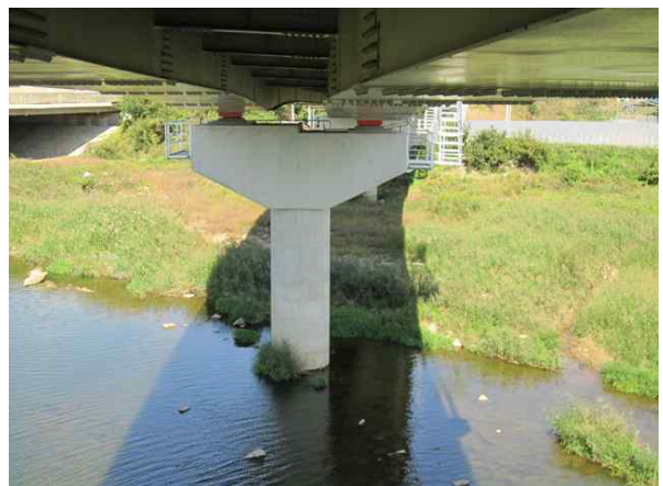
교량 하부 전경
