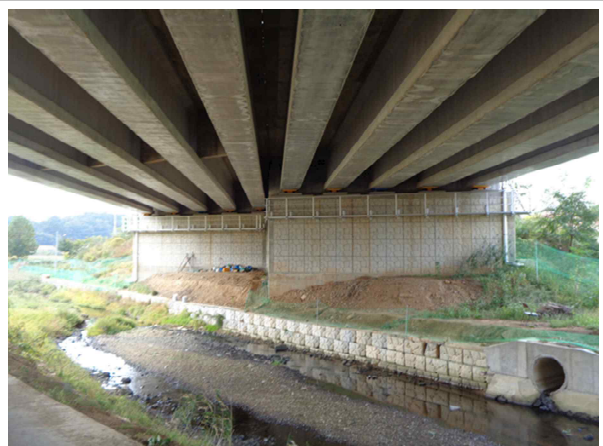
교량 하부 전경
