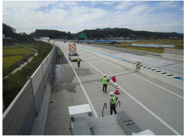
교량 상부 전경
