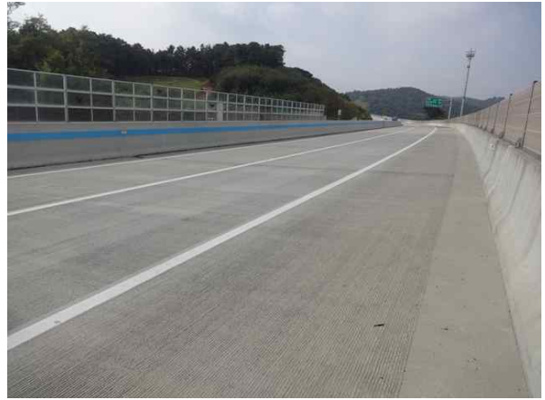
교량 상부 전경
