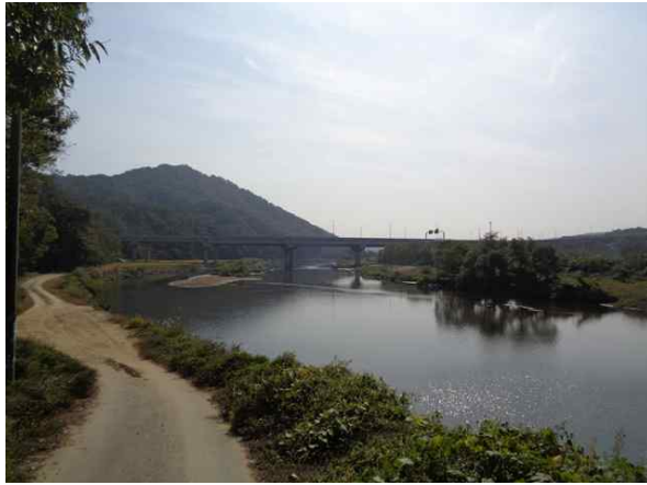
교량 측면 전경
