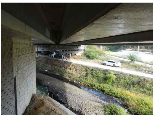
교량 하부 전경
