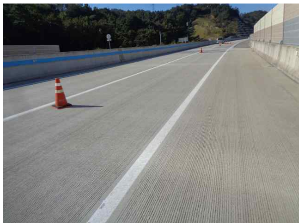
교량 상부 전경
