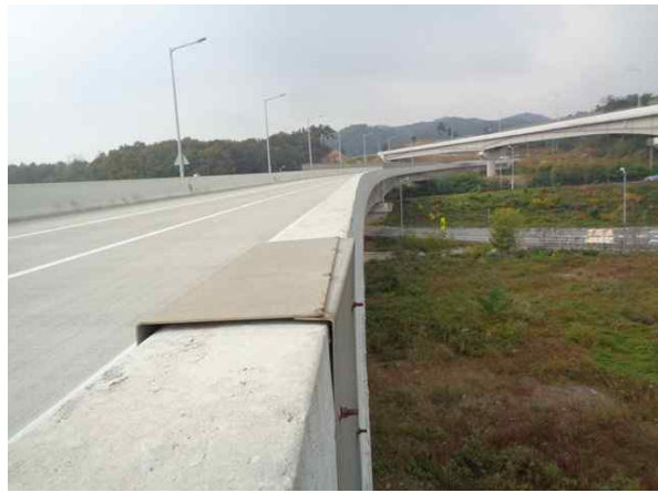
교량 측면 전경
