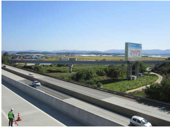
교량 측면 전경
