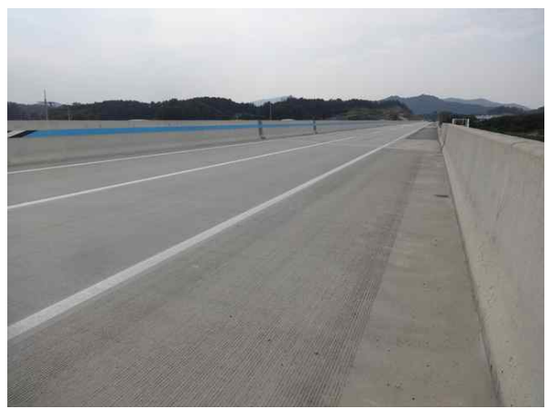
교량 상부 전경
