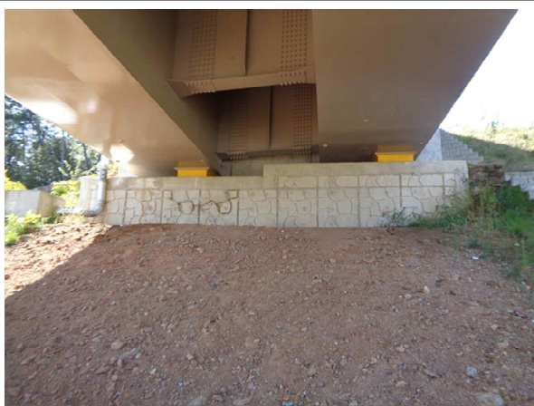
교량 하부 전경
