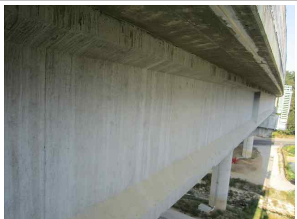
교량 거더 전경
