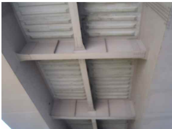
교량 바닥판 전경
