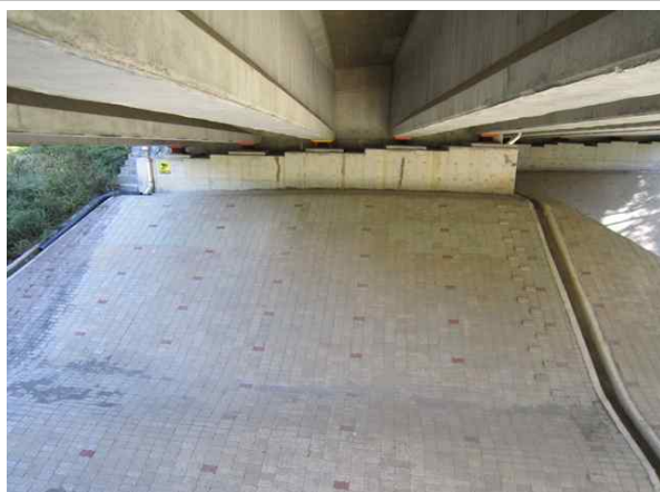
교량 하부 전경
