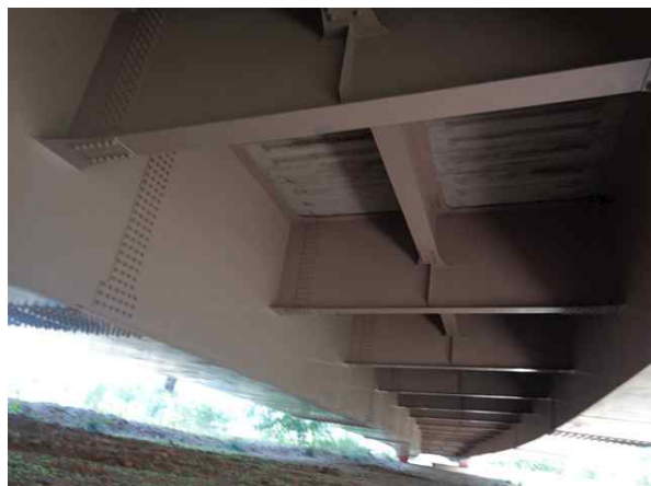
교량 바닥판 전경
