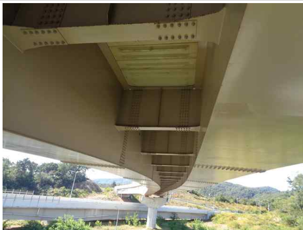
교량 바닥판 전경
