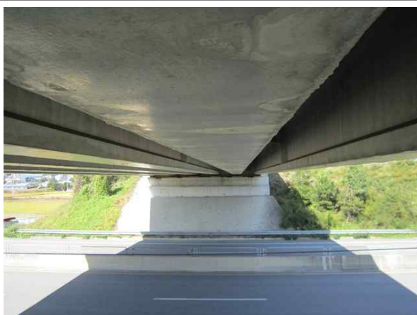
교량 하부 전경
