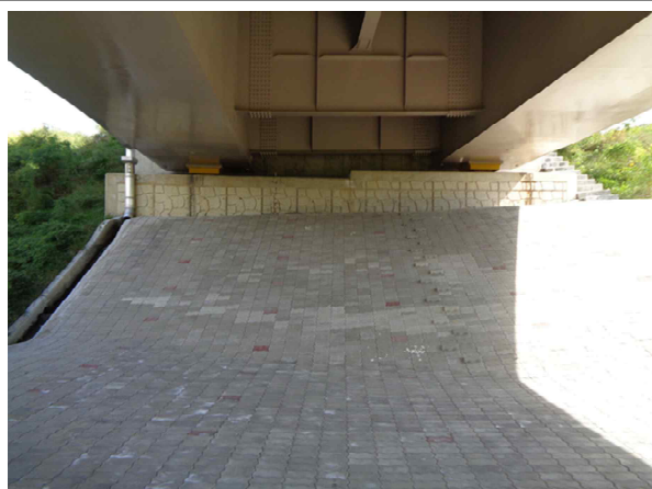
교량 하부 전경
