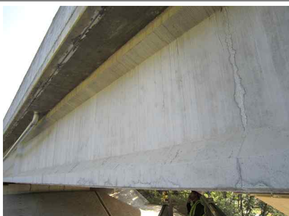
교량 거더 전경
