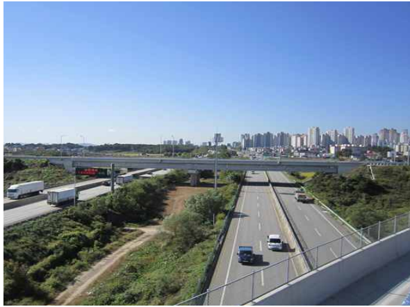
교량 측면 전경
