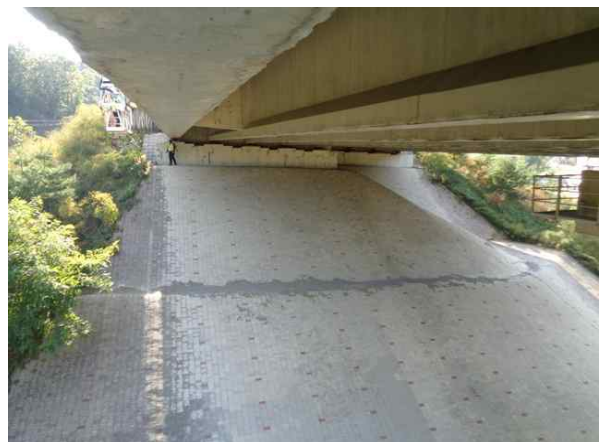
교량 하부 전경
