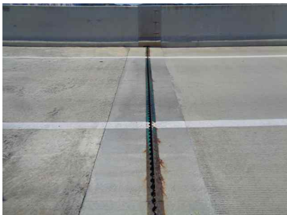
교량 상부 전경
