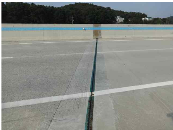
교량 상부 전경
