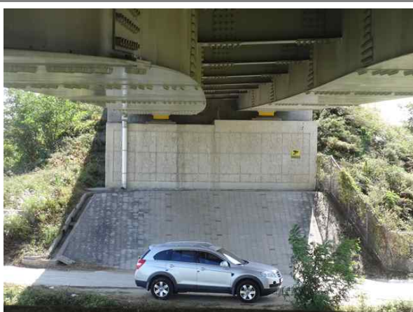
교량 하부 전경
