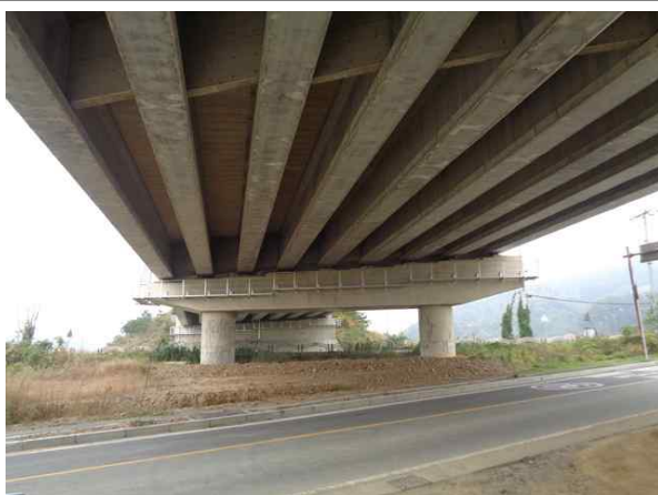
교량 하부 전경
