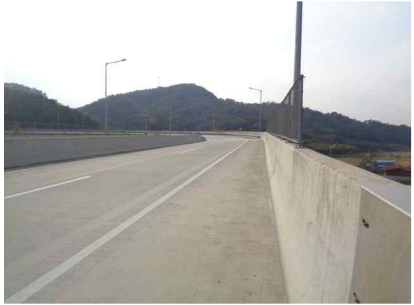
교량 상부 전경
