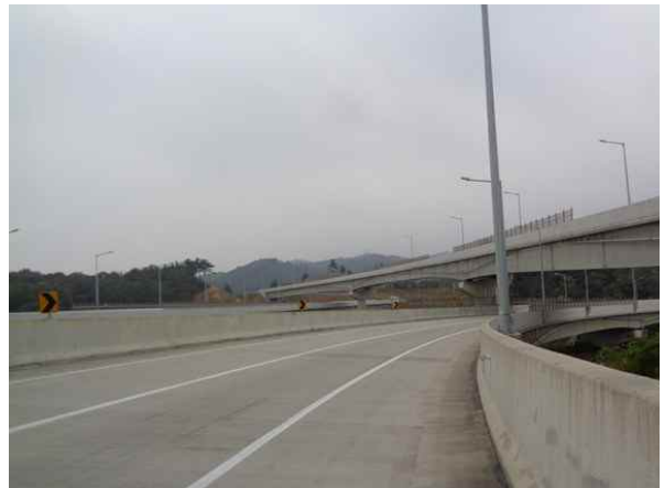
교량 상부 전경
