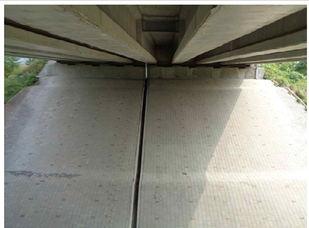
교량 하부 전경
