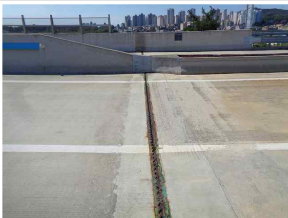
교량 상부 전경
