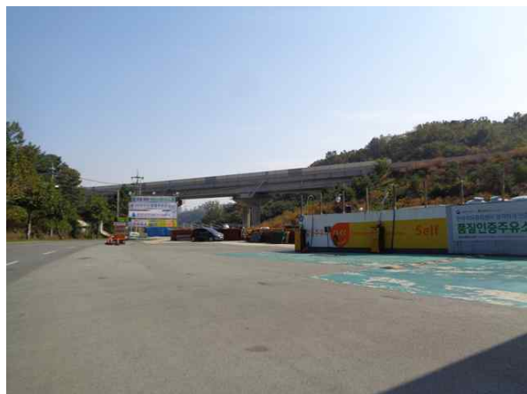
교량 측면 전경
