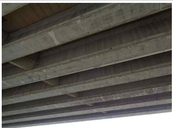
교량 거더 전경
