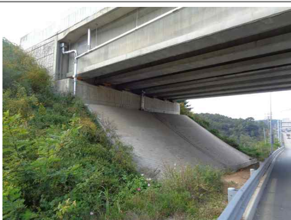
교량 하부 전경
