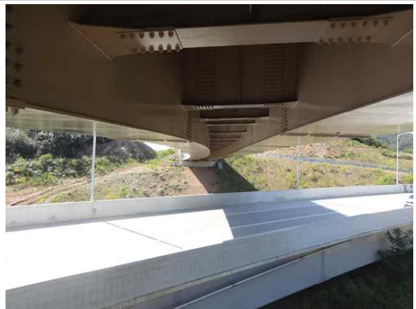
교량 거더 전경
