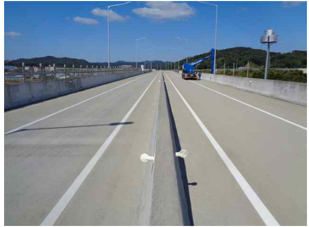
교량 상부 전경
