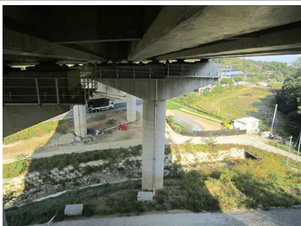
교량 하부 전경
