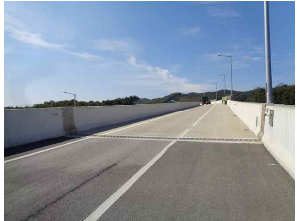
교량 상부 전경
