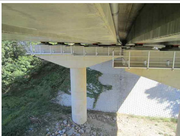
교량 하부 전경
