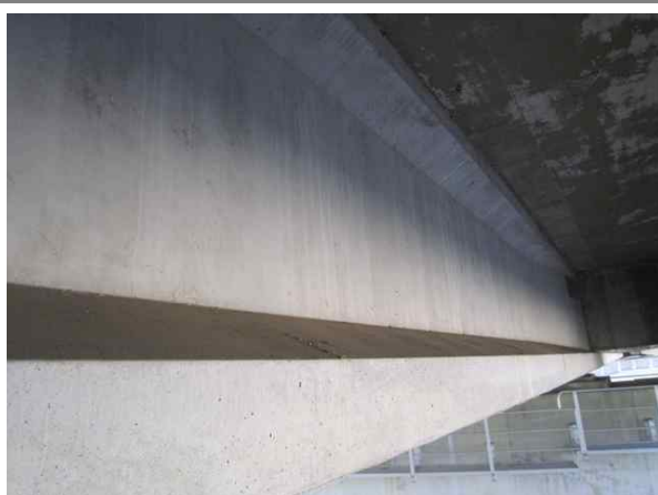
교량 거더 전경
