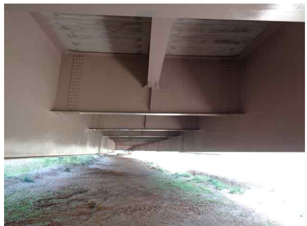
교량 거더 전경
