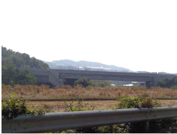
교량 측면 전경
